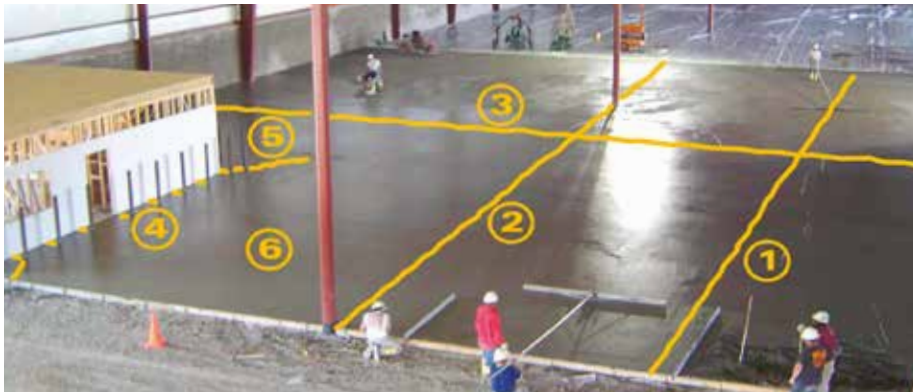
System-K™ Pour at the Sofa Express Warehouse (Portland, TN)
