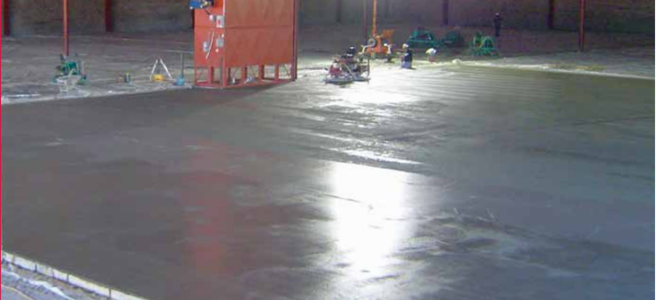
System-K™ Pour at Sofa Express Warehouse (Portland, TN)
